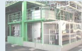
濃厚フッ酸廃液に石灰を加え、流動性を保ちつつ無希釈で中和し、更に乾燥させて産廃量を削減した例(廃棄物量を半分以下に削減)
